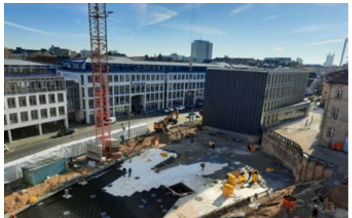
Gießen der Bodenplatte Quelle: Birgit Ritschel, ZBFS
